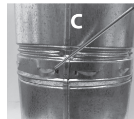
C Pour déverrouiller le DuraLock, soulevez toutes les lances. Tourner le joint légèrement et séparer le joint.
